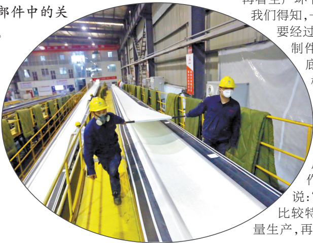
车间里工人们为叶片主梁铺层。(本报记者 罗轶 摄)
