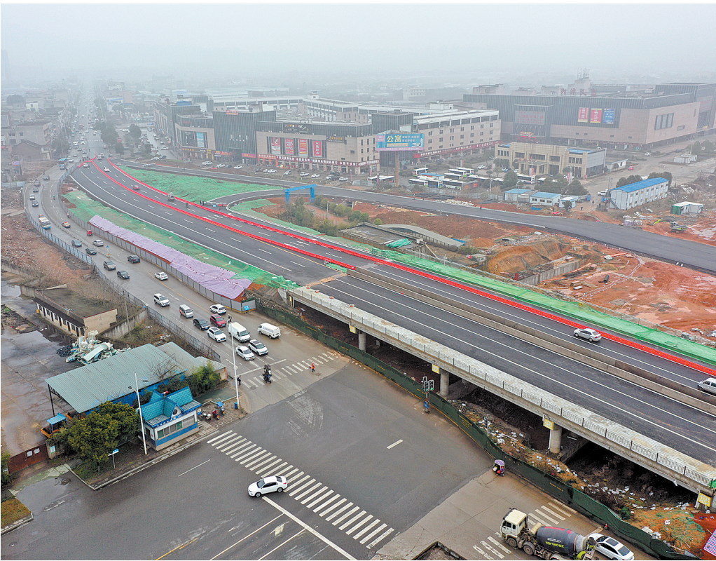
2月4日,航拍新建成通车的羊牯立交桥。(本报记者 方阳 摄)
