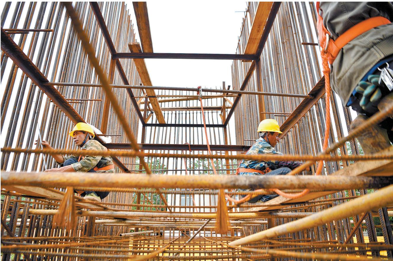
▲ 杨梅洲大桥项目“五一”不停歇,为抢抓工程进度,施工方组织力量施工。5月4日,在施工现场,工人们正在焊接、绑扎钢筋,制作桥墩钢筋笼。(本报记者 罗翰 摄)
