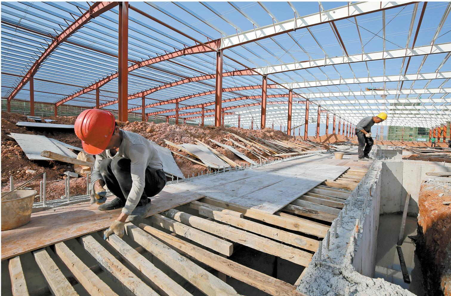
▲ 5月1日下午3时,为抢抓工期,彭强及工友在炎热的太阳下为浇筑下风道装模。我市重点产业项目——九华新纤维智能纺纱项目建设在提速,34217平方米的厂房主体建设已进入扫尾阶段。“五一”期间,项目方组织了200多人的队伍,着手砌墙、喷涂等施工。
