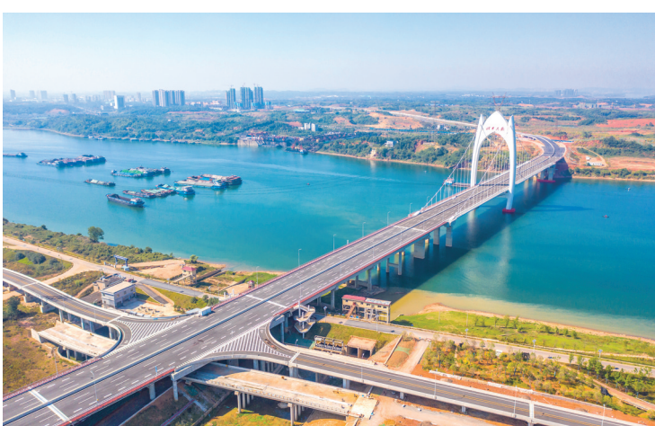
竣工后的昭华大桥。
