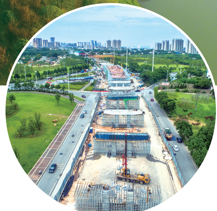
芙蓉大道快速化改造项目建设现场。
