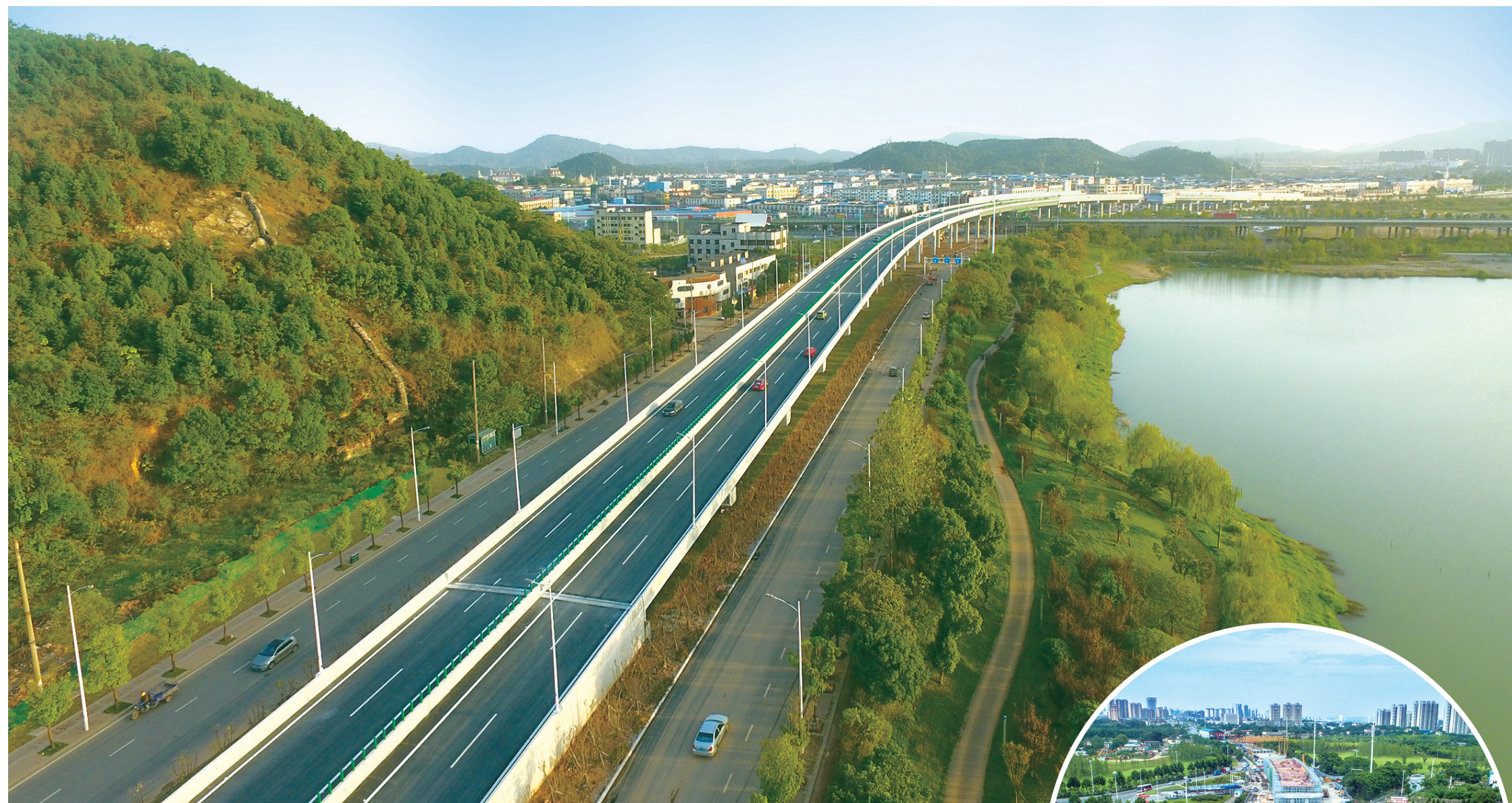
快速化改造后的芙蓉大道全线通车。
