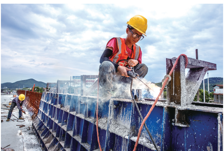
工人正在对芙蓉大道高架桥上的模板进行焊接安装。
