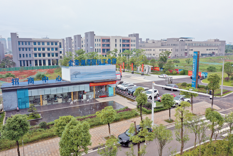
湘潭金棠国际工业园一期一批完成交付,二期二批正加快装饰装修。(方阳 摄)
