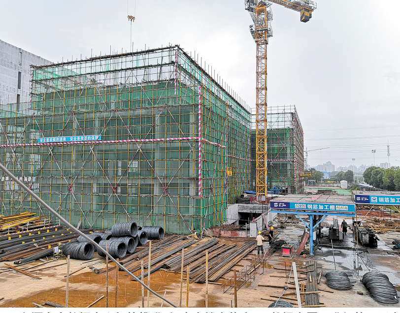
湘潭市大数据中心加快推进,机房大楼主体完工,数据大厦正进行第五层主体结构浇筑。
