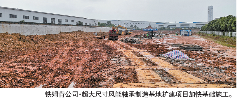
铁姆肯公司·超大尺寸风能轴承制造基地扩建项目加快基础施工。
