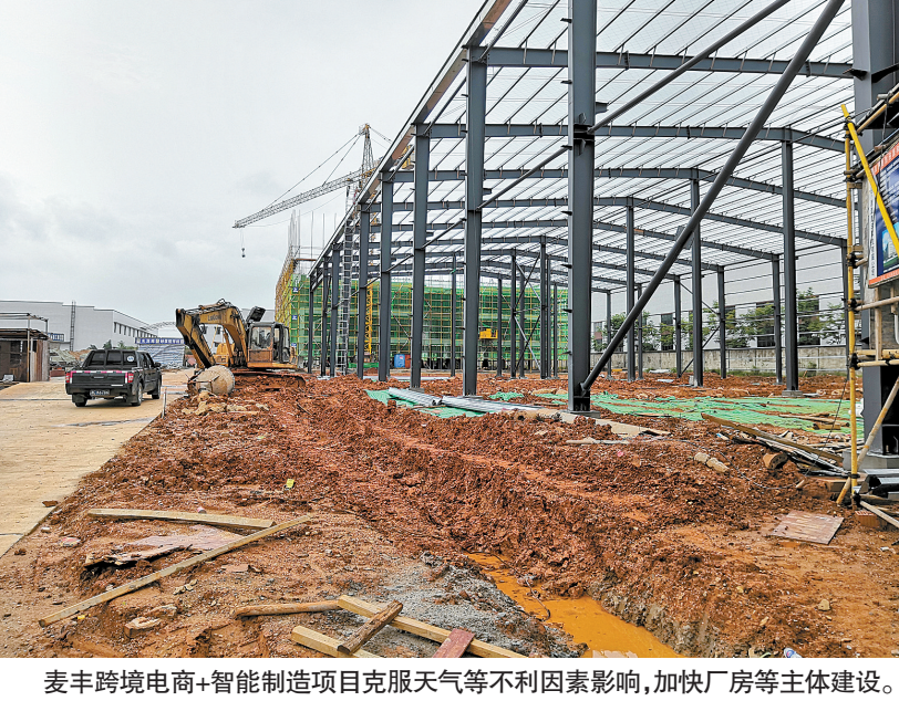
麦丰跨境电商·智能制造项目克服天气等不利因素影响,加快厂房等主体建设。
