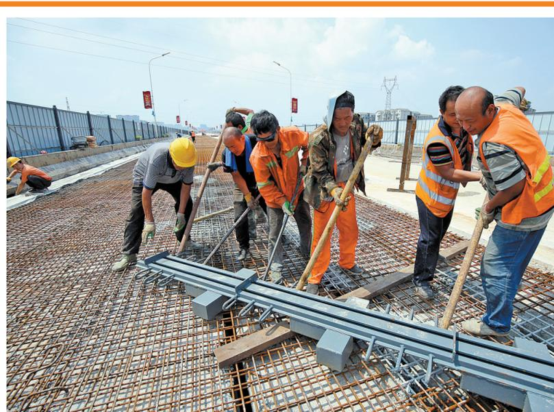
6月1日,施工人员正在对二大桥桥面伸缩缝进行施工作业。记者从二大桥维修加固项目指挥部了解到,自封桥施工以来,高新集团和各参建方建立了严密的职能管理体系,层层落实责任,抢抓时机加班加点组织施工。目前该项目已完成总体工程量的90%以上,接下来将对北引桥面180米长的半幅桥面进行混凝土浇筑,以确保如期通车。(本报记者 李新辉 摄影报道)
