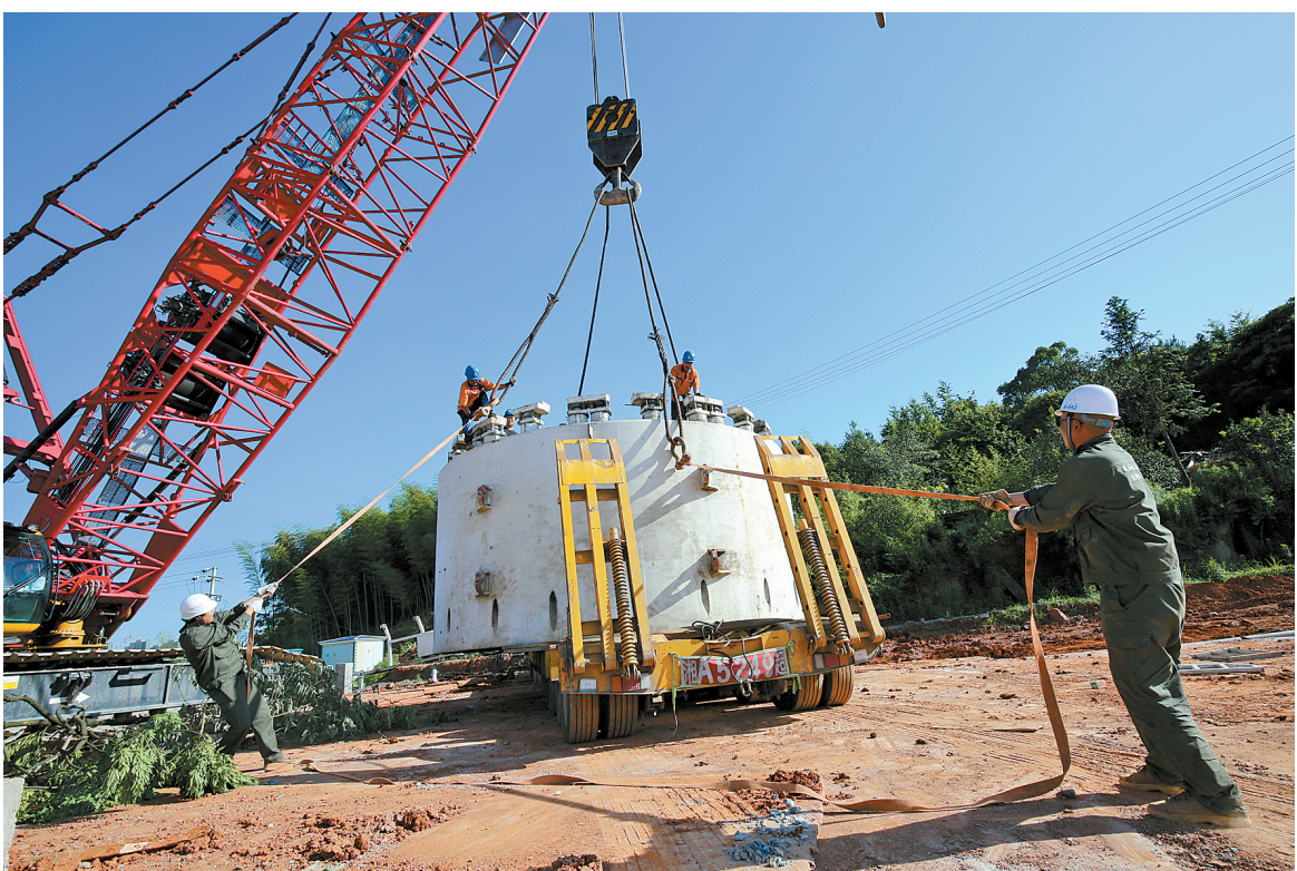
6月5日,在长株潭城际西环线湘北区间下穿湘潭北站节点处,中建五局土木工程有限公司将首台盾构机100吨左右的主要构件缓缓吊装下井。长株潭城际西环线湘北区间总长1.8公里,其中下穿湘潭北站隧道并列两个,每个长约709米,首台盾构机在装配调试好后将于本月开挖,标志着该项目区间进入盾构施工阶段。据了解,第二台盾构机计划于本月20日左右下井。盾构机每天可掘进约12米,完成这项工程预计为3个月。(本报记者 李新辉 摄)
