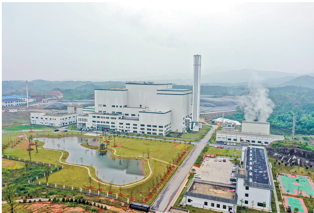
湘乡市龙洞镇投入使用的垃圾焚烧发电站。(本报记者 方阳摄)
