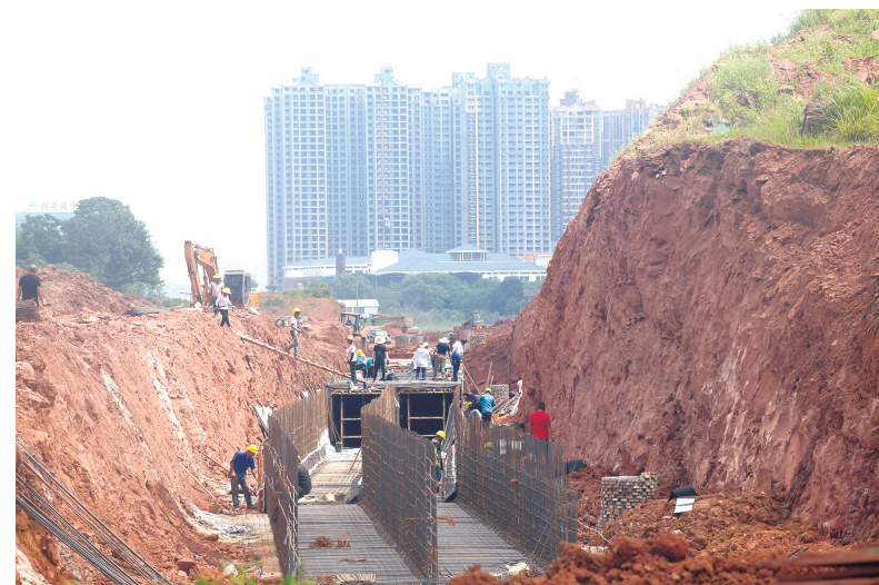
湘潭路抢抓好天气浇筑排水箱涵。(方阳 摄)
