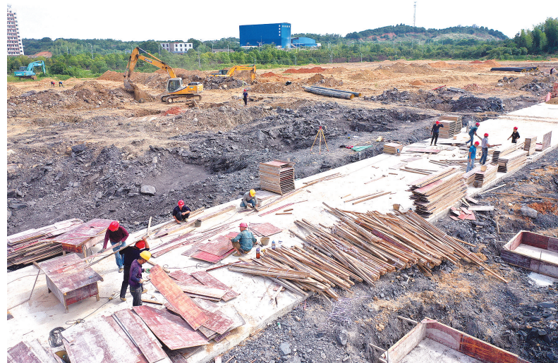
湘潭柏屹自主创新产业园二期正在进行基础施工。(方阳 摄)
