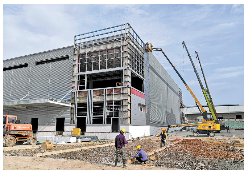
湘潭凯依克物流园二期项目主体已完工,正进行外墙彩钢板安装。
