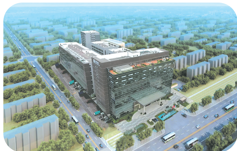
怡亚通(湘潭)供应链整合基地
