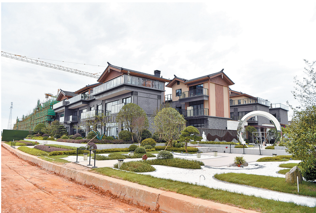
十八总·中国城总文化国际旅游度假区项目正在抓紧施工中。(本报记者 罗翰 摄)
