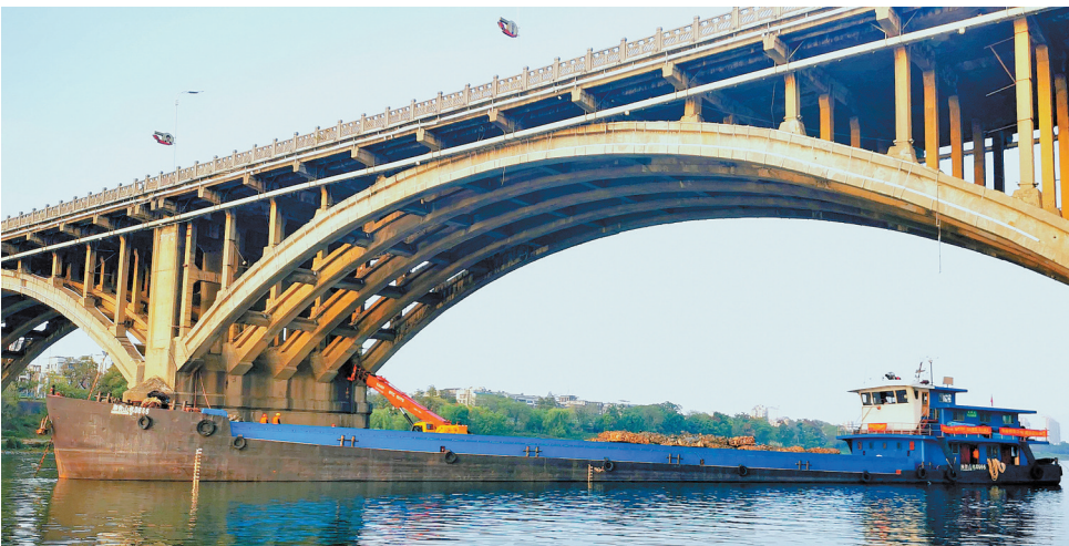
10月27日,运输船运送吊车、块石、吨包至湘潭一大桥桥墩下作业。(本报记者 汤俊 摄)
