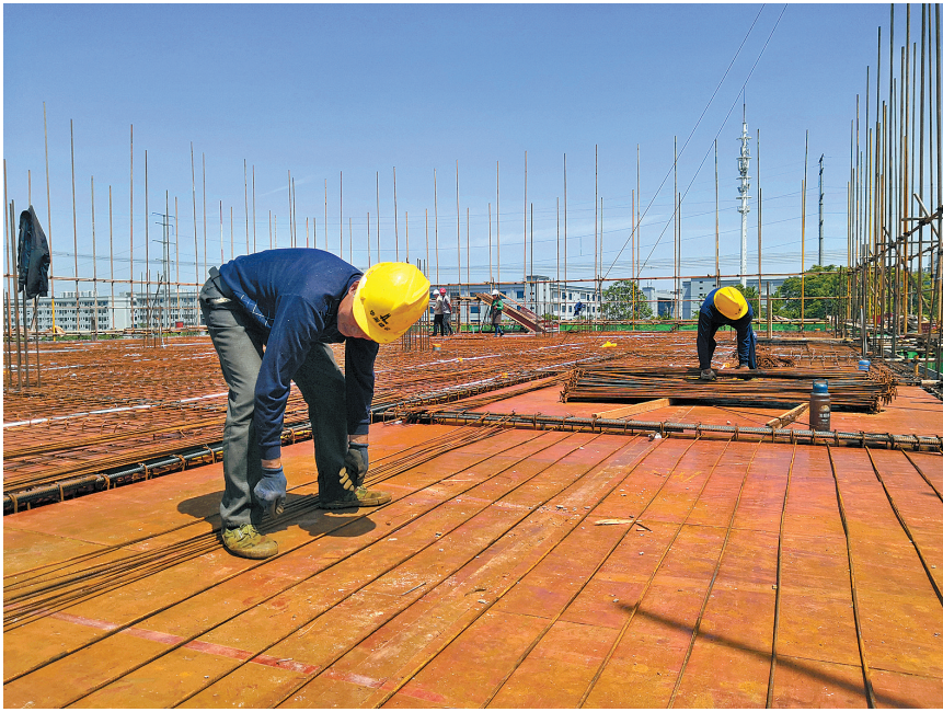
湘潭经开区永灵医疗项目多层框架结构厂房正在进行三层楼面钢筋捆扎。(本报记者 马贵摄)
