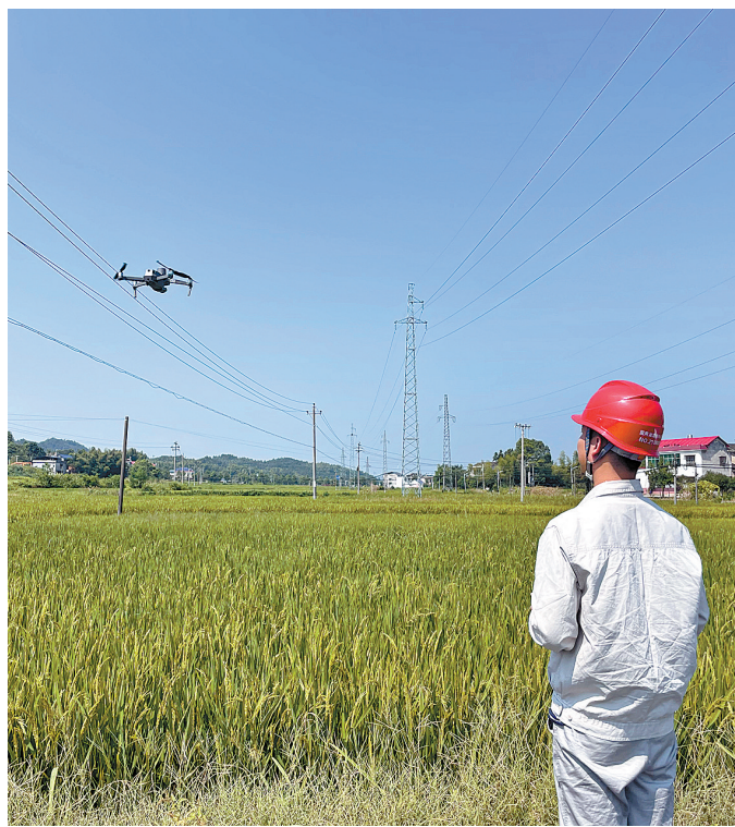
国网韶山市供电公司工作人员在韶山市杨林乡对10千伏杨万线开展智慧巡检。
