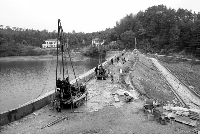
湘潭县青山桥镇高屯村高屯水库除险加固施工现场。（本报记者 李新辉 摄）
