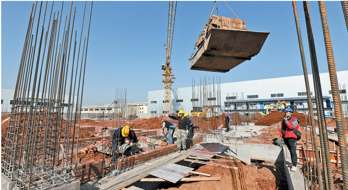
施工现场一派繁忙。(本报记者 李新辉 摄)
