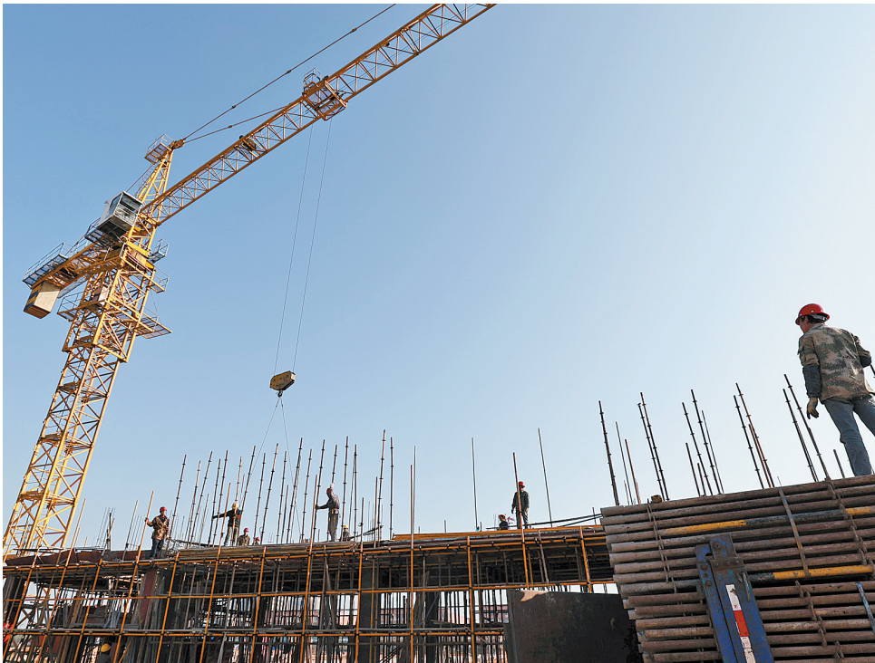
在湘潭柏屹智能装备配件园项目现场，项目建设全面铺开，一派热火朝天的施工景象。（本报记者 李新辉 摄）
