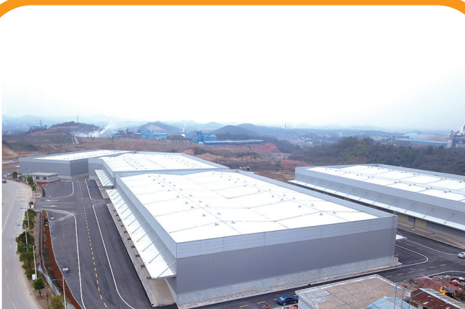
一力物流公路港（一期）。
