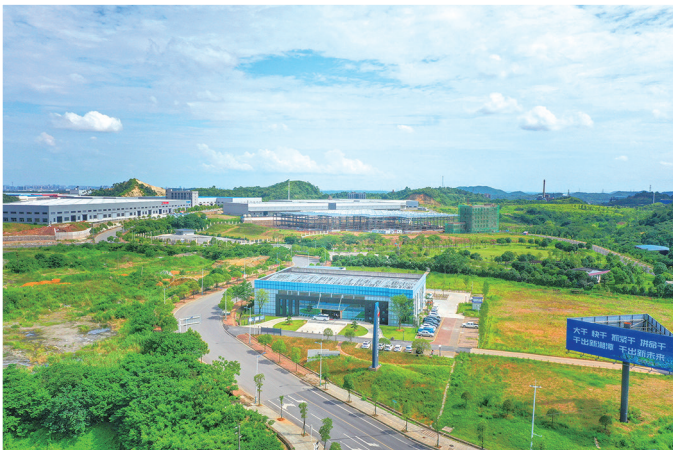
雨湖高新区航拍。（本报记者 方阳 摄）
