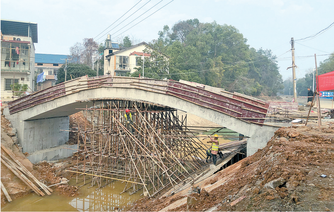
近日,在韶山灌区北干渠石竹塘地段,施工人员在抓紧扫尾横跨灌渠的人行道改造工程(见图)。去年入冬启动的韶山灌区“十四五”续建配套与现代化改造项目,对渠内防渗衬砌、人行桥改造、渠道除险加固等进行重点改造与建设,目前项目进展顺利。(本报记者 李新辉 摄)
