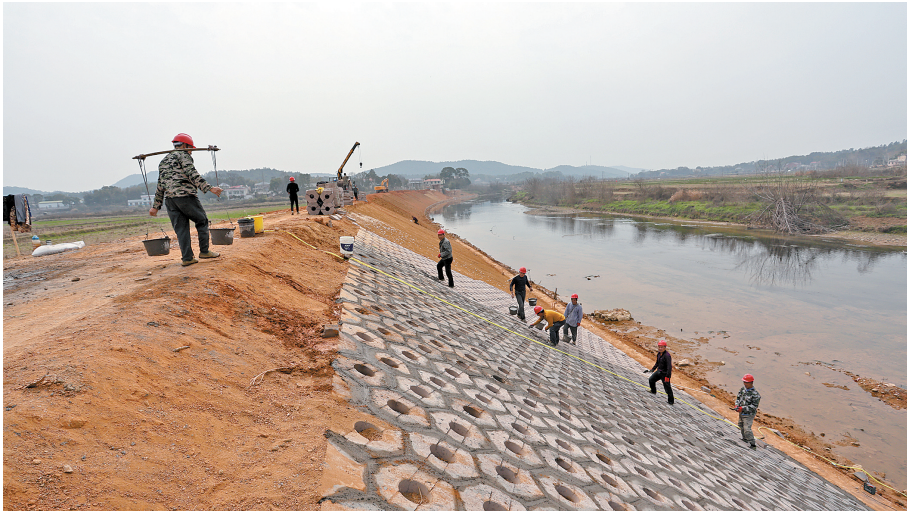
3月7日，雨湖区鹤岭镇龙头岭村靳江河治理工程项目施工现场，工人正在铺贴护坡生态砖。
