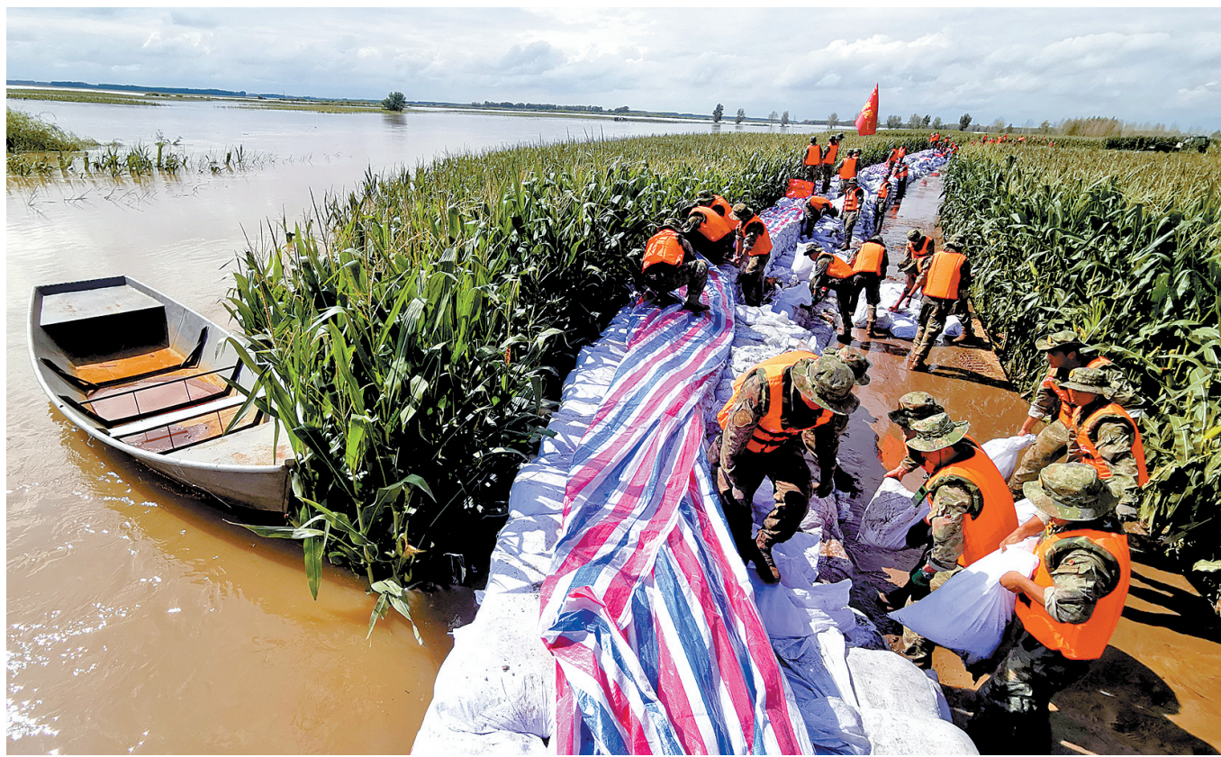
8月8日,陆军第78集团军某旅官兵在黑龙江哈尔滨市双城区增产村进行堤坝加固封堵。(新华社记者 张永进 摄)
