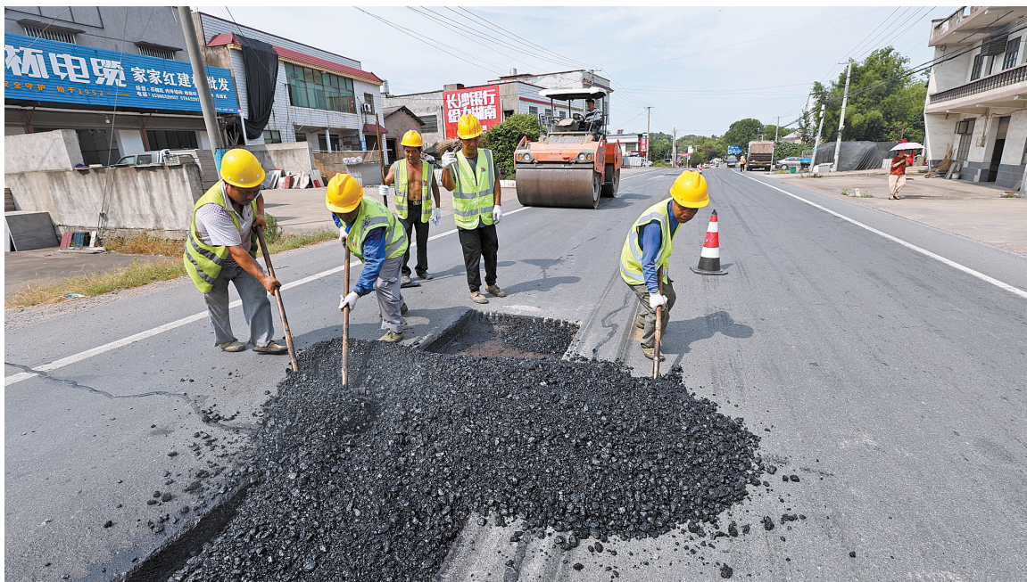
G320湘潭段路况提升工程中,城发建工采用了水泥路面就地“冷再生”工艺铺设沥青路面。(本报记者李新辉实习生鄢鸿志摄)
