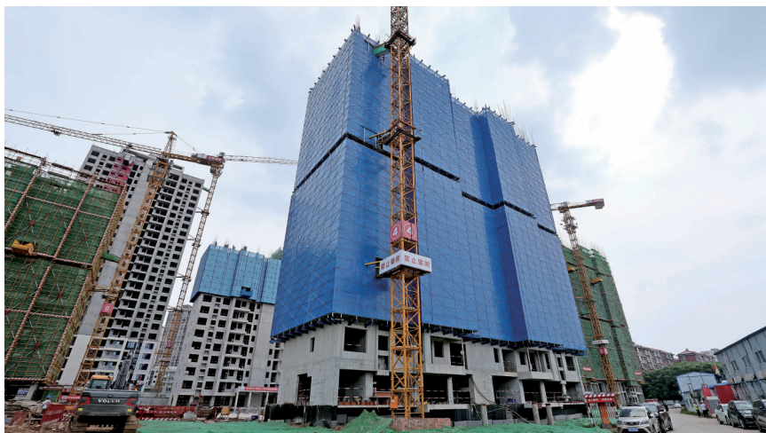
湘潭产“新型智能化悬挑式脚手架”(图中蓝色部分)在雨湖区广云路“和平央著”建设项目上应用效果良好。(本报记者 李新辉 摄)
