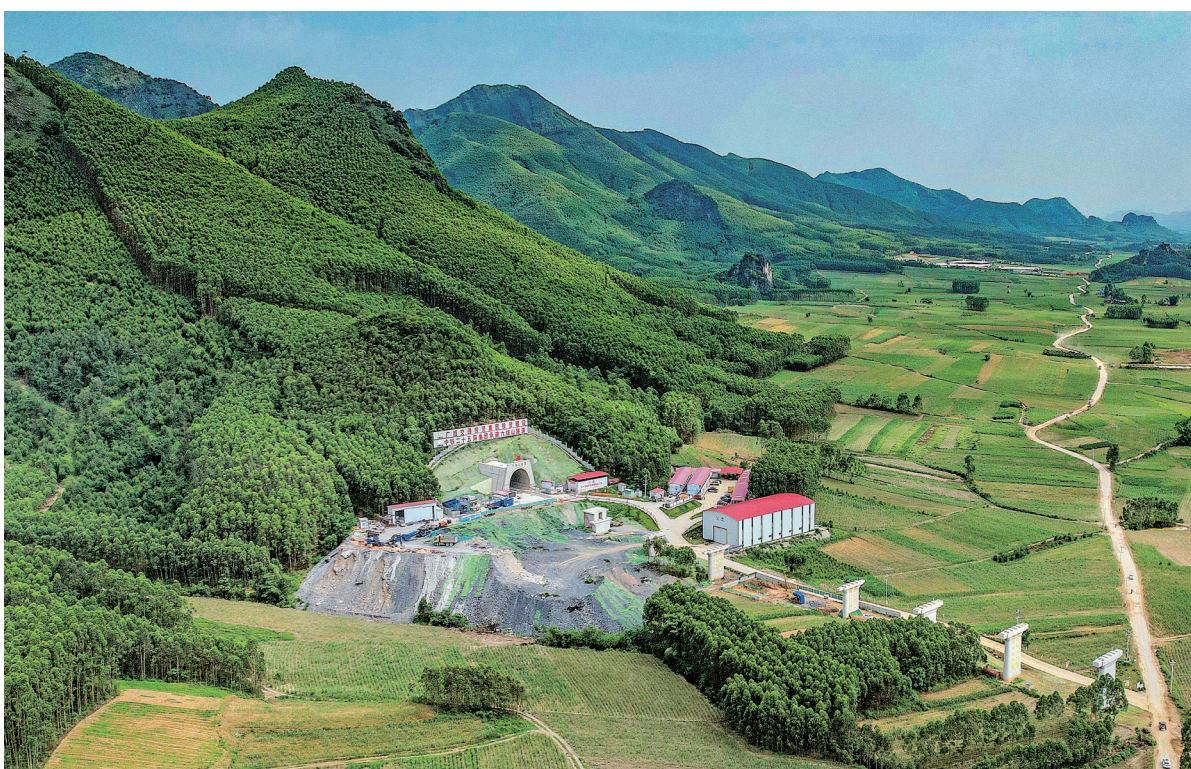
5月14日，广西柳梧铁路首个中长隧道——六绵山隧道顺利贯通，隧道全长2865米，为单洞双线隧道。柳梧铁路正线全长238.167公里，设计时速160公里，项目计划2026年竣工。
