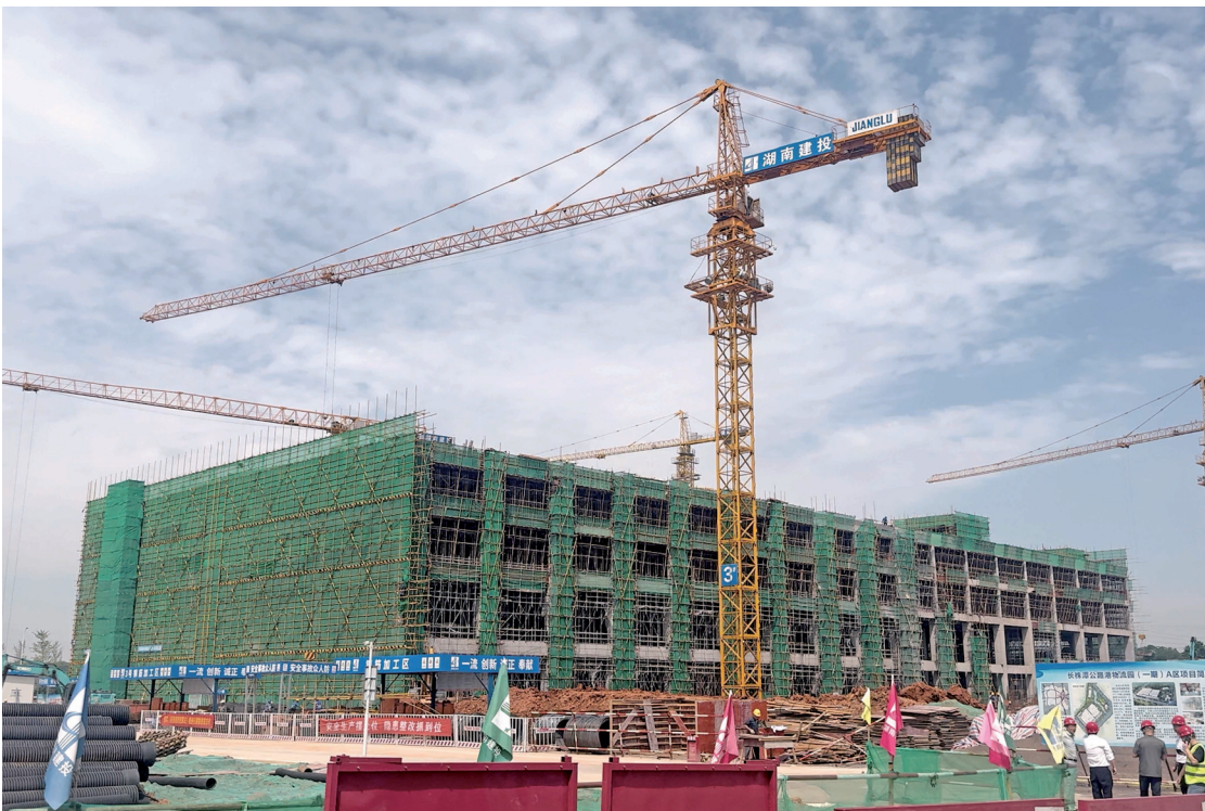
顺丰物流中心主体大楼已基本成型。(本报记者 谭涛 摄)
