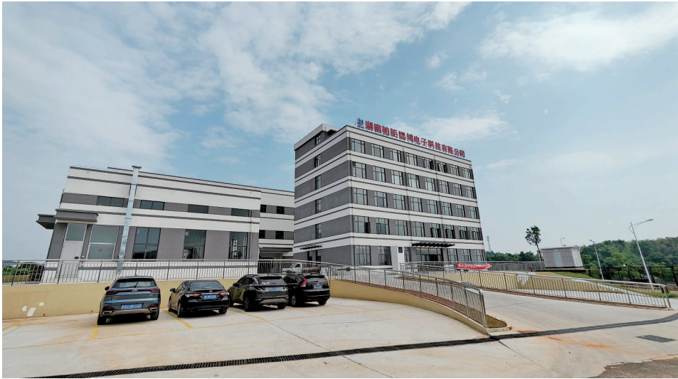
湖南铂钨医药器械生产项目主体已完工,正在进行内部装修的细节调整。(本报记者 马贵 摄)
