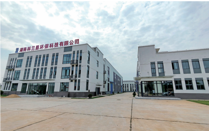
湖南科兰恩生产基地项目建设进入扫尾阶段,设备即将进场并安装调试。 (本报记者 马贵 摄)
