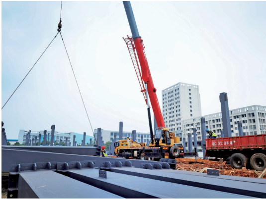
钰盛科技项目现场吊装钢梁。
