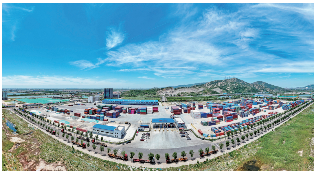
2024年6月26日拍摄的位于江苏省连云港市连云区的上合组织(连云港)国际物流园内的中国外运集装箱场站(无人机照片)。上合组织(连云港)国际物流园是连云港建设“一带一路”交汇点强支点和上合组织国家出海基地的重要平台载体。(新华社记者 季春鹏 摄)
