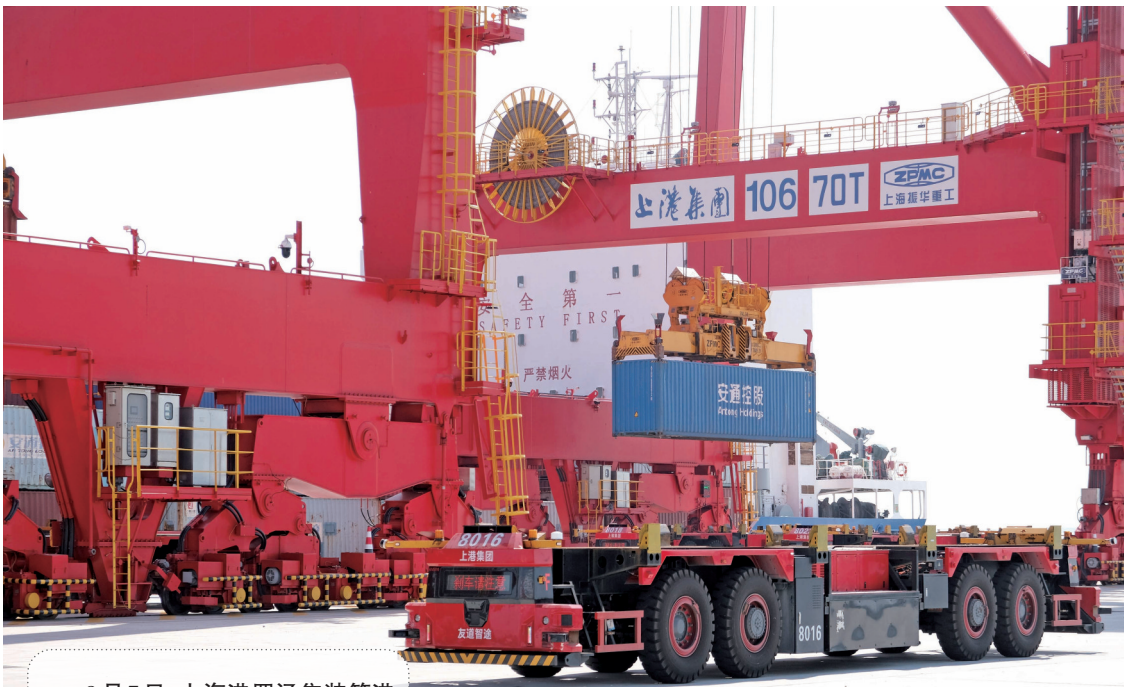
8月7日，上海港罗泾集装箱港区一期的龙门起重机在码头作业。（新华社 发 周心怡 摄）
