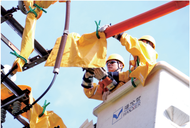
国网湘潭供电公司不停电作业中心旁路作业班在执行不停电作业任务。
