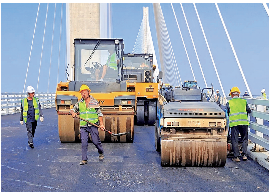
压路机正在压实沥青。（本报记者 谭涛 摄）
