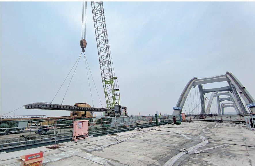
桥面板吊装作业。(本报记者 谭涛 摄)
