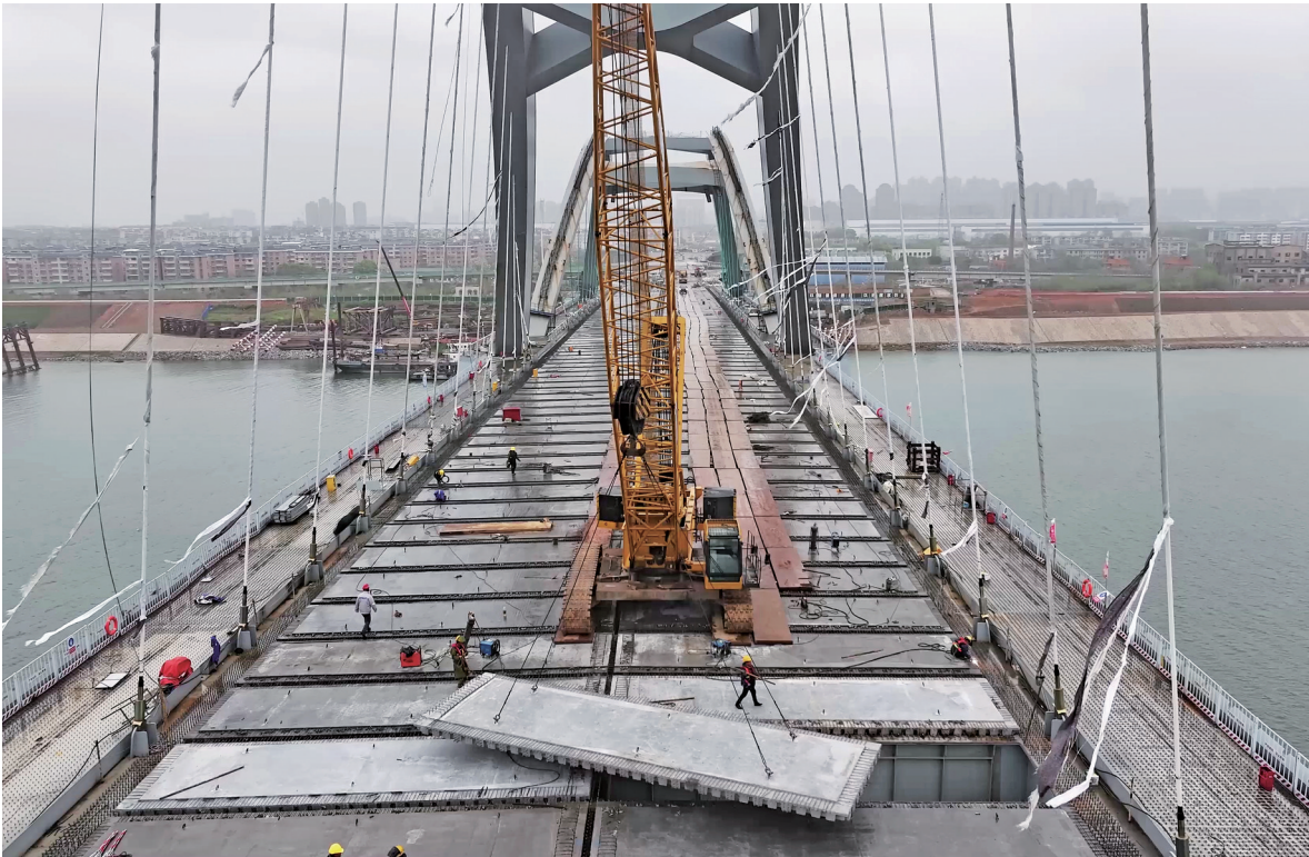
下摄司大桥最后一块桥面板吊装。(本报记者 谭涛 摄)
