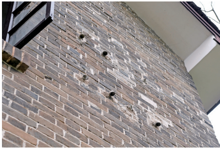
墙体上有8个供接纳通信线缆穿墙而过的弯头瓷筒。(本报记者 罗轶 摄)
